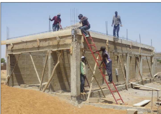
Construction du Centre Donniyaso
